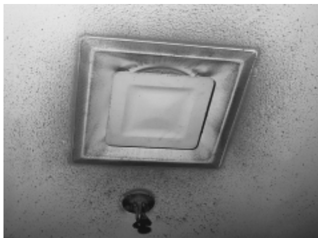
Diffuseur dont la propreté est douteuse Source : Pierre Auger
