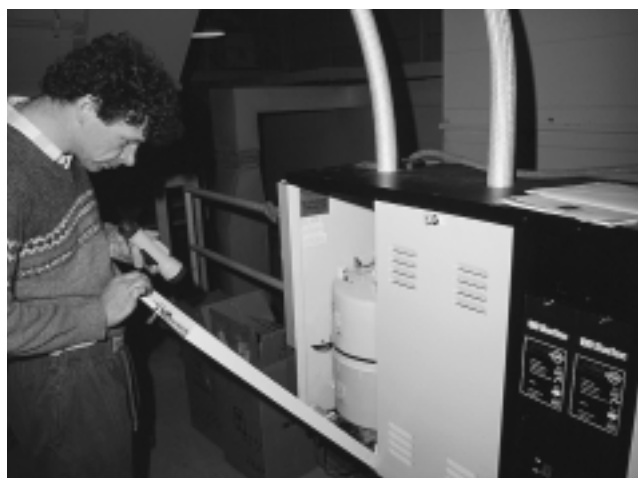
Humidificateur à injection de vapeur saturée
